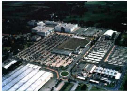
Abb. 21: Luftaufnahme des Sonderstandortes „Dodenhof“ in der Gemeinde Ottersberg. Die enorme Flächenversiegelung ist erkennbar.
